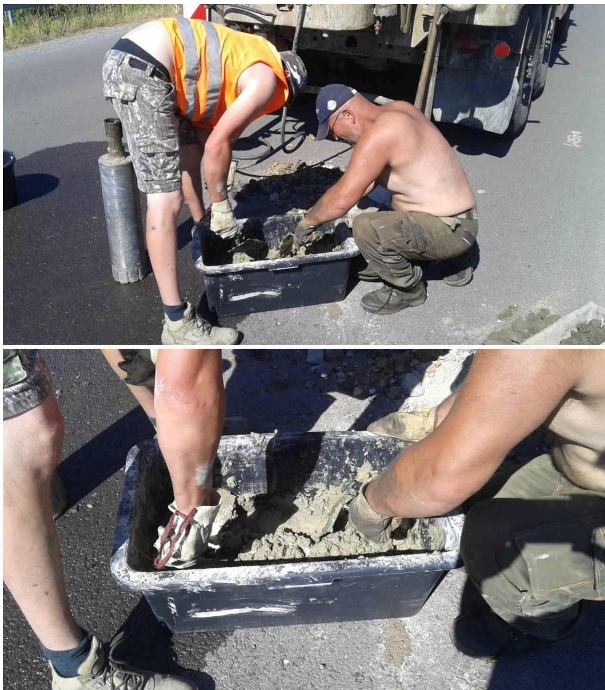
Foto 11, 12 Příprava jílocementové směsi
